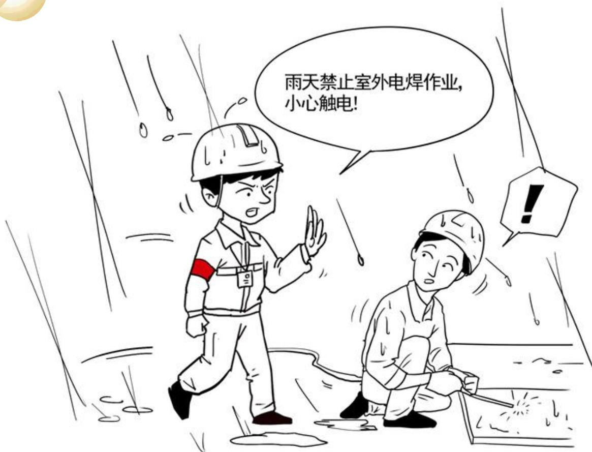
雨天禁止露天施焊；在潮湿的场所焊接时人必须站在干燥的木板或橡胶绝缘片上。
