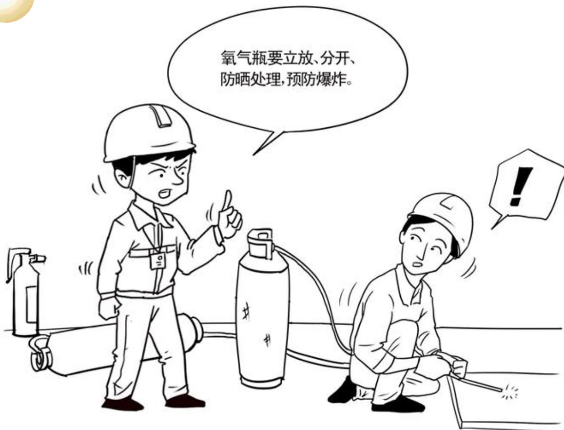
易燃易爆气瓶禁止敲击、碰撞。不得靠近热源，气瓶间距须大于5米，与明火的距离须大于10米并采取隔离措施、防止暴晒。现场气瓶使用时严禁倾倒、禁止卧放。
