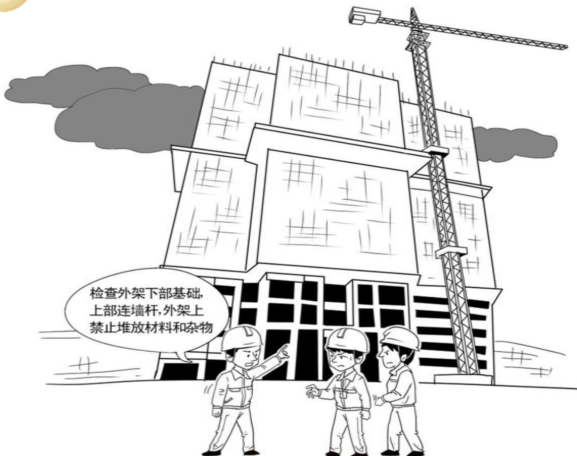
暴雨来临前须检查脚手架基础排水是否可靠有效, 外架连墙杆设置是否符合规范及方案要求, 外架上禁止堆放材料与杂物。
