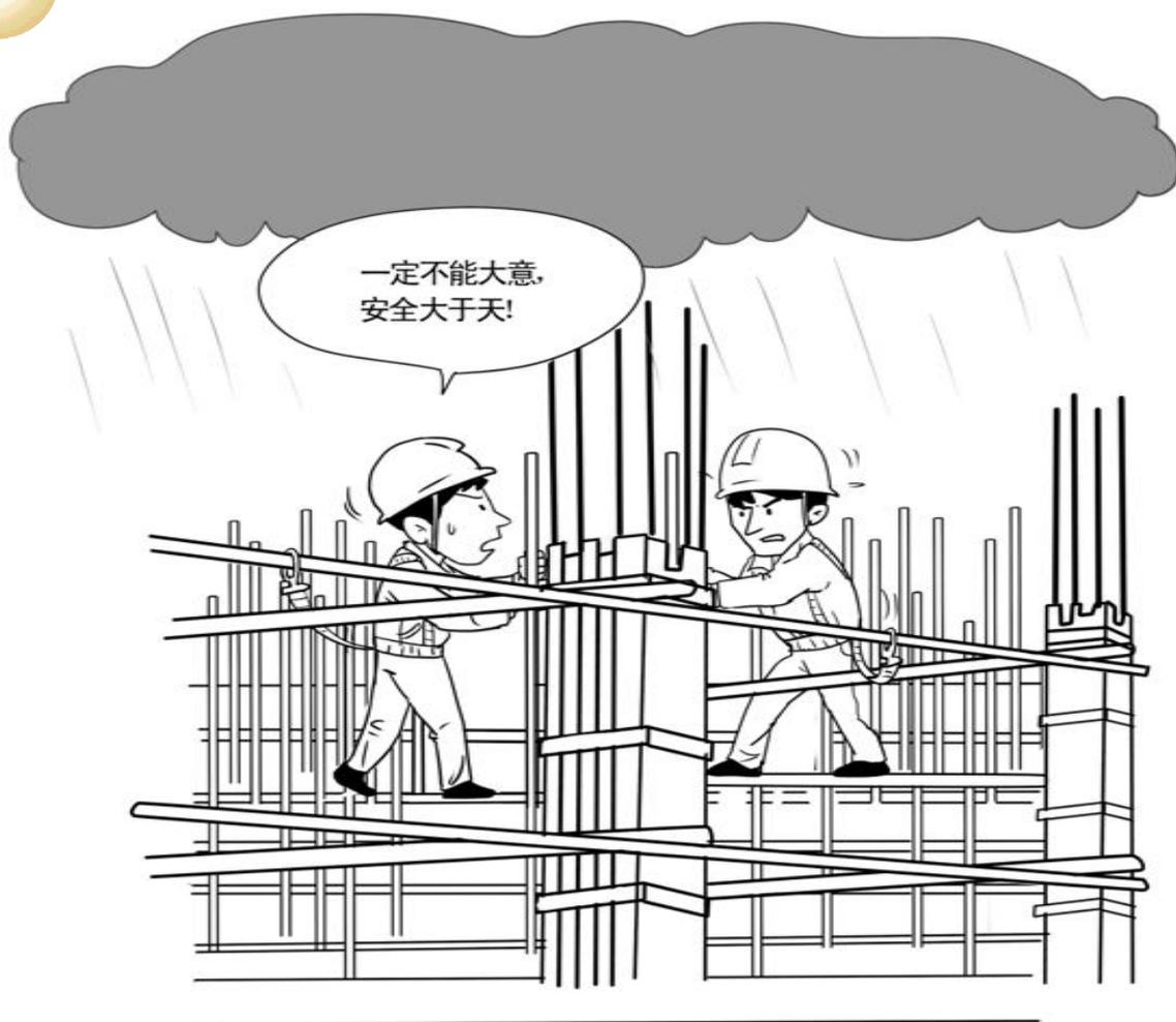
暴雨前须卸除支撑体系上部荷载，对支撑体系进行加固确保基础排水畅通有效。
