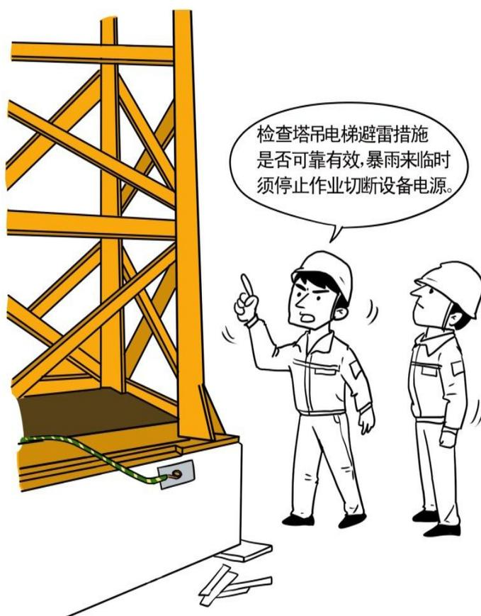
暴雨来临前须确保高于建筑主体的塔吊、施工电梯、钢结构构件等大型设施设备防雷措施可靠有效，并在暴雨来临前停止作业切断设备电源。
