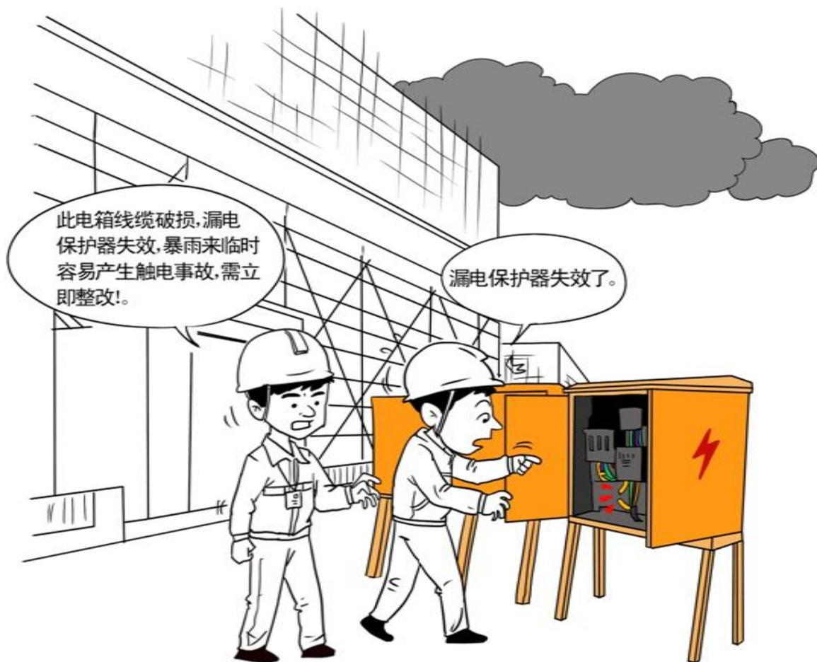
暴雨来临前须对项目临时施工用电进行专项检查，检查电气设备是否处于低洼地带，是否有防雨措施，电缆是否有破损；电线绝缘接头是否良好；接零、接地保护措施是否牢固；漏电保护器是否灵敏有效；暴雨来临时除照明、排水、抢险用电外的其他电源都须切断。
