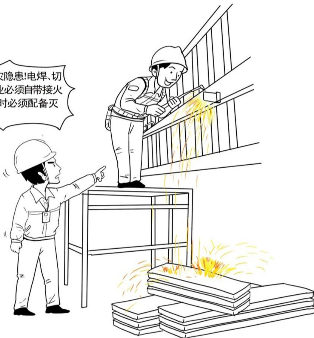
焊接、切割作业必须使用接火斗,金属切割作业要设置遮挡措施,防止火星飞溅造成可燃物着火,须配备灭火器材。
