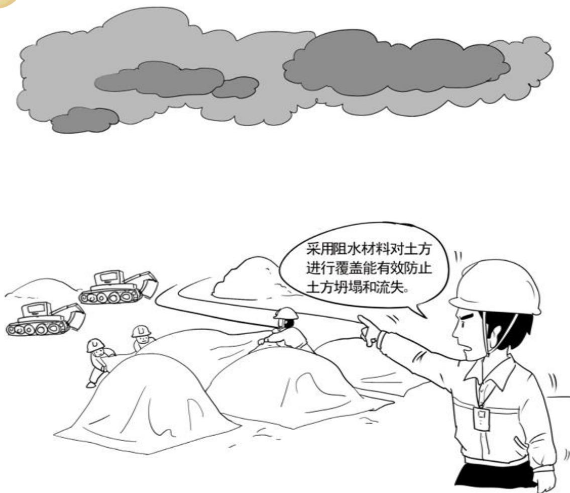
暴雨来临前宜对项目土方使用尼龙布等防水材料覆盖，防止雨水渗透导致土方的坍塌和流失。
