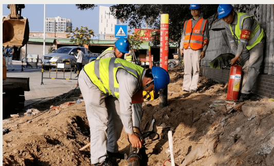
燃气管道检修更新
