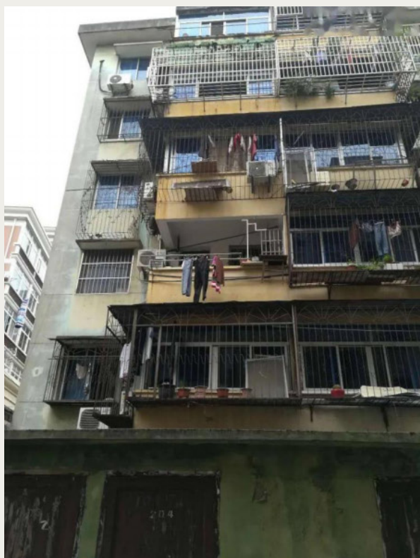
建筑外窗改造前
