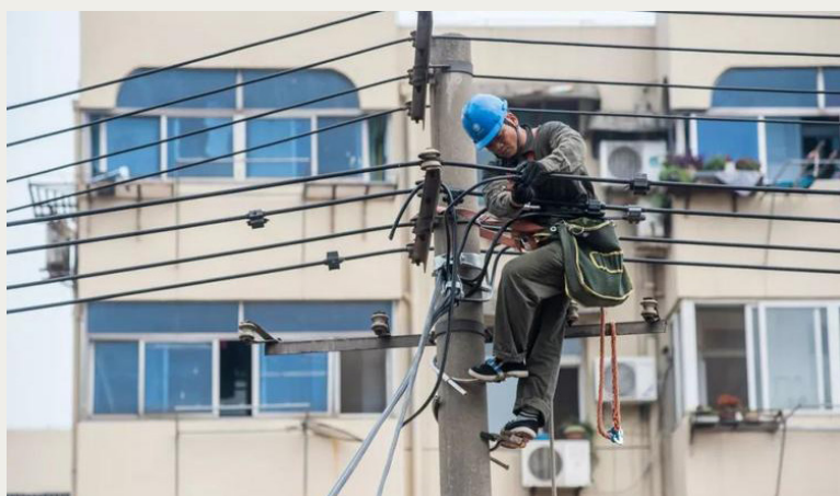
老旧线路检修更新
