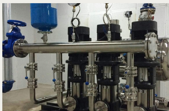
管网无负压供水设备示意
