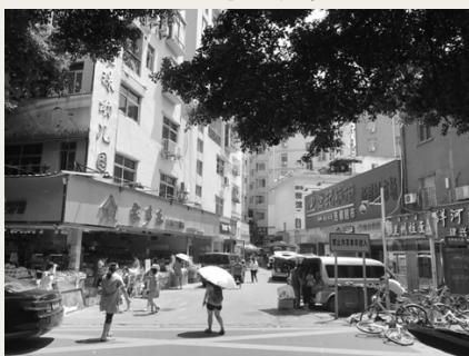
沿街外立面改造前
