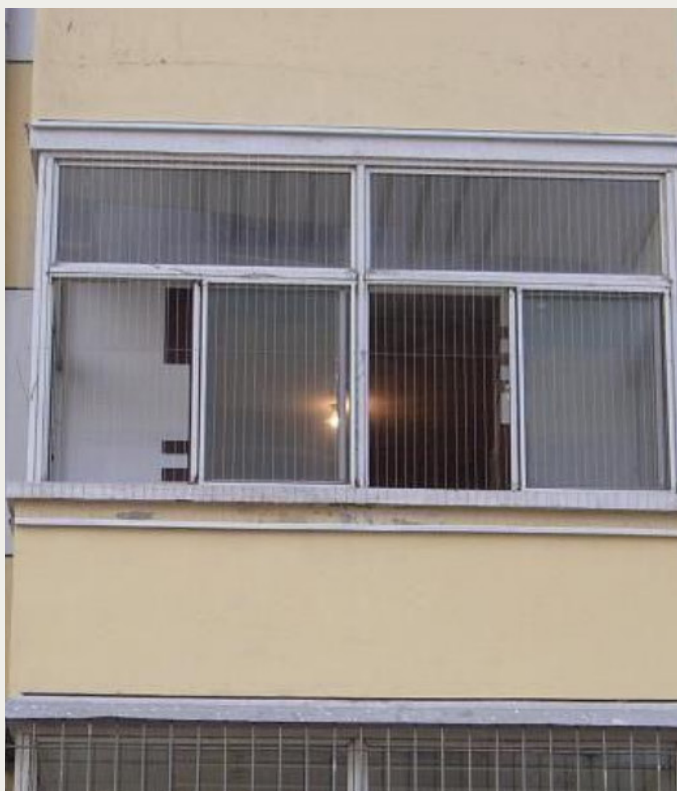
建筑外窗改造后
