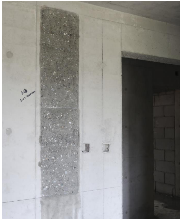
图 E.0.2 混凝土结构体的表面磨抛
