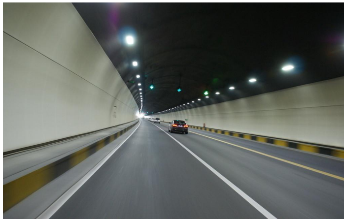
图10 隧道内防火复合铝板装饰效果（来自网络图片）
