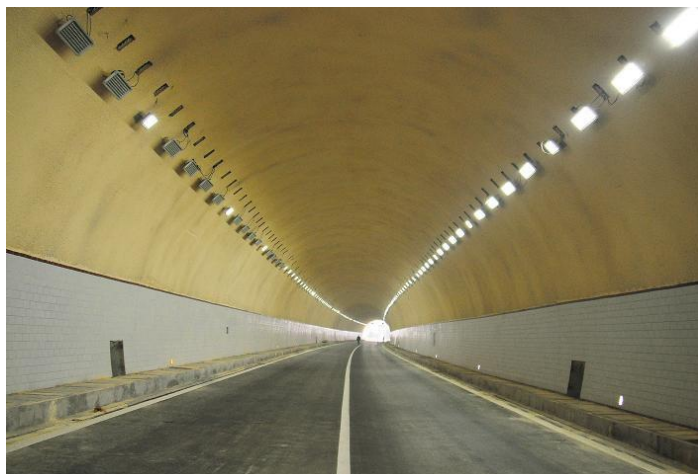
图11 隧道内瓷砖装饰效果（来自网络图片）
