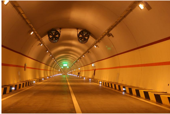
图 12 隧道内防火涂料装饰（来自网络图片）
