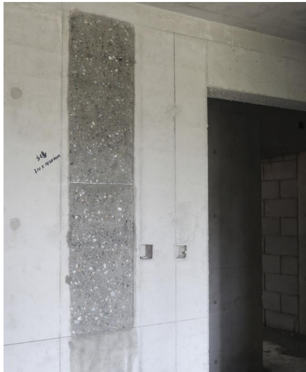
图 E.0.2 混凝土结构体的表面磨抛
