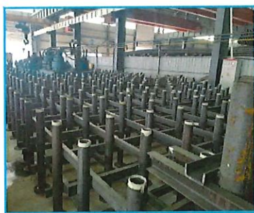
加载孔套管工厂化制作，形成单元块，整体安装，每个加载孔顶部设置可调节套管
