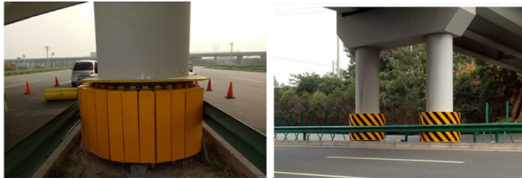
图5.6.4.2 新型桥墩防撞装置示意图
