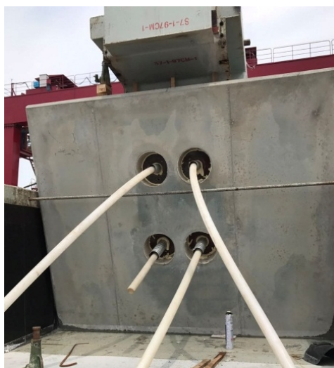
图 5.3.1.7 某桥预制盖梁深埋锚具示意图
