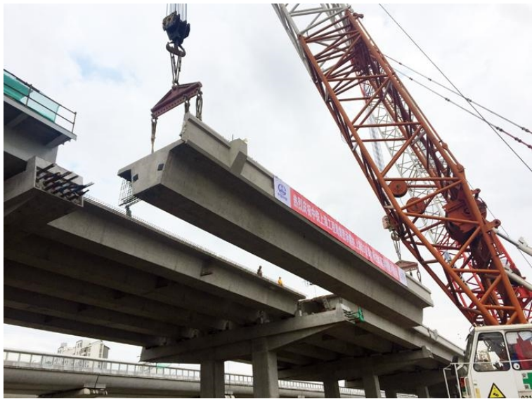
图 5.2.1.4 小箱梁与防撞栏杆整体吊装示意图
