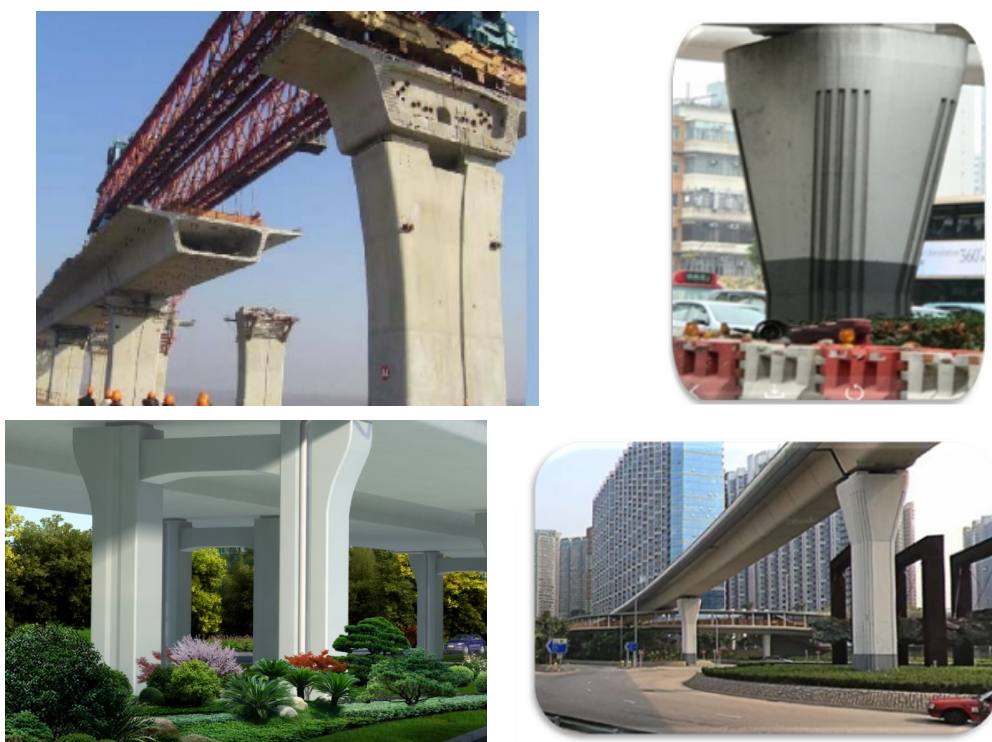
图 4.5.7 桥墩刻槽示意图
