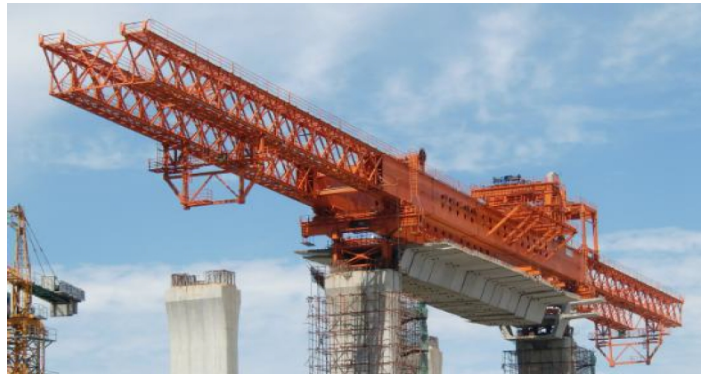
图 5.2.1.1 架桥机架设节段预制梁示意图
