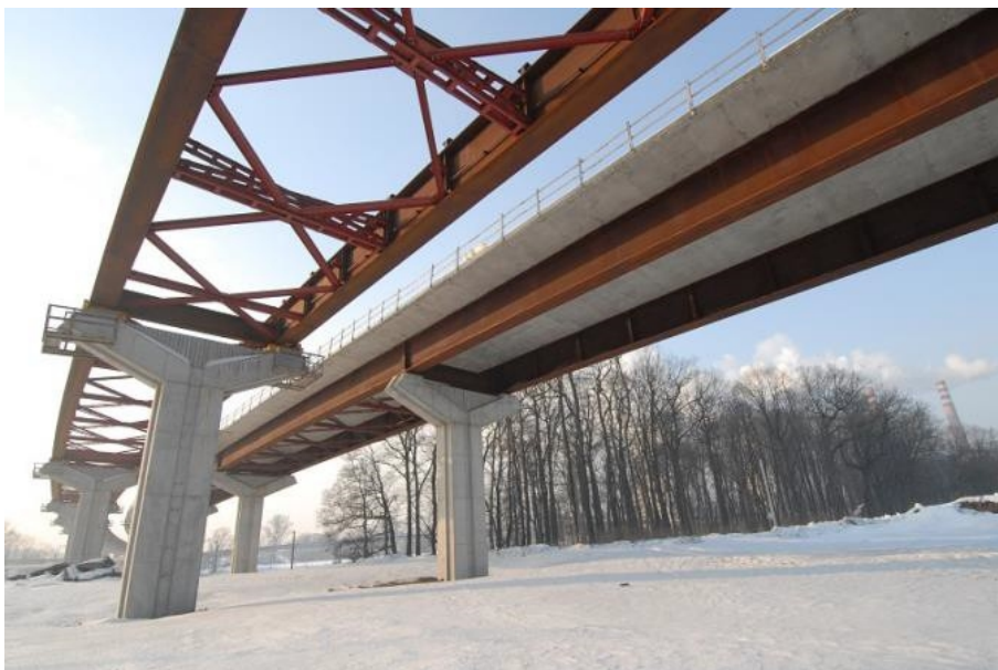
图 5.2.3.10 组合钢板梁实桥图
