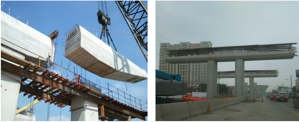
图 5.3.1.1 盖梁分段预制示意图
