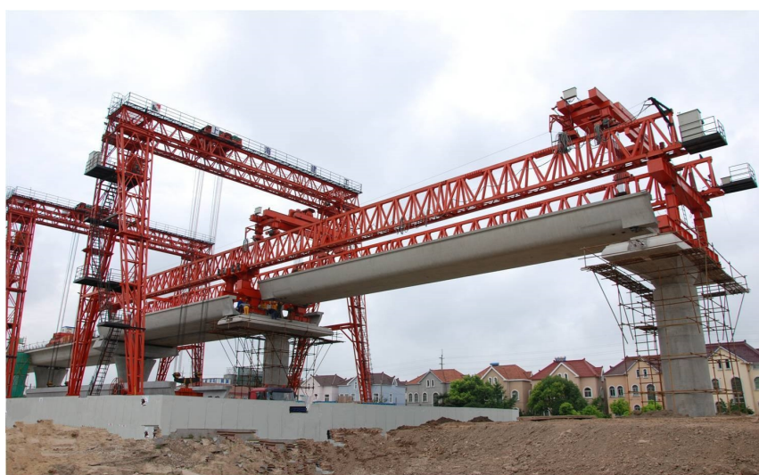
图 5.2.1.3 架桥机吊装预制整孔大箱梁示意图
