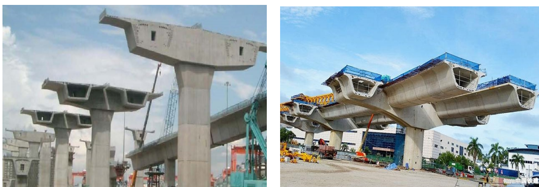
图 5.2.1.2 悬臂吊装节段预制梁示意图
