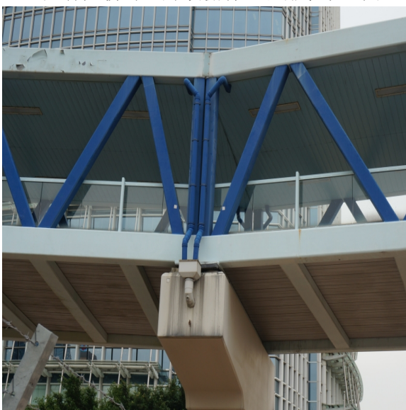
图7.2.5.1 顶棚两侧排水
