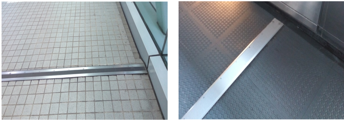
图 3.0.10.3 实桥伸缩缝照片
